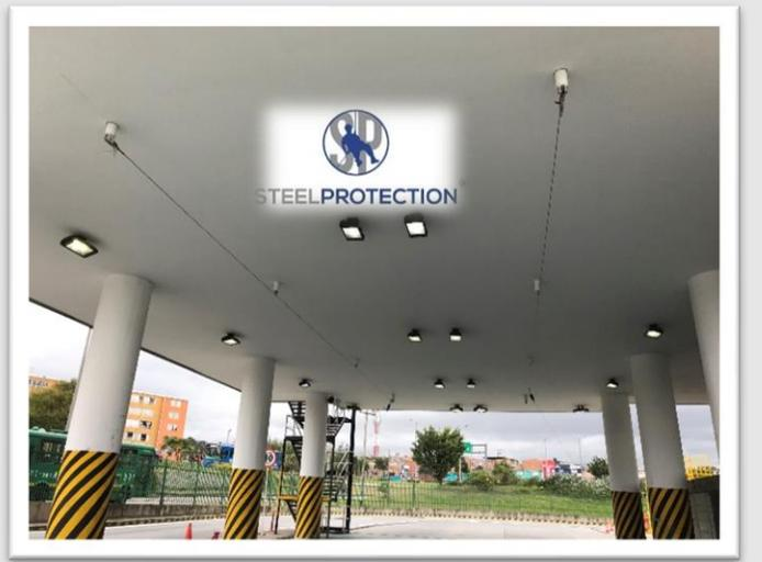
Permiten realizar un mantenimiento seguro en la parte superior de los vehículos, son fabricadas en cables de acero y cuentan con absorbentes de impacto que protegen al trabajador de lesiones al momento de una caída.
